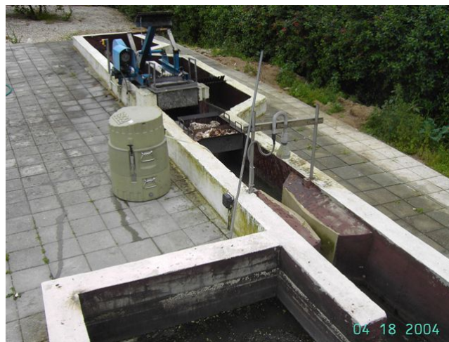
Figura 16 – Exemplo de amostrador portátil para colheita de afluente a uma ETAR de pequena dimensão
